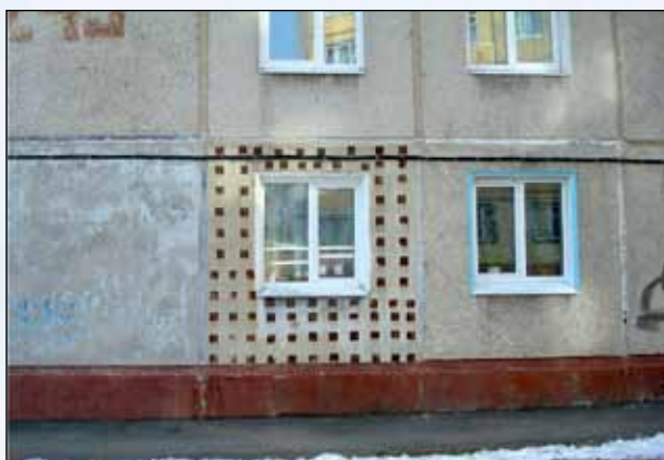
Усиление аварийной панели наружными стальными анкерами (Севастопольская, 249, год постройки – 1972 г.).
