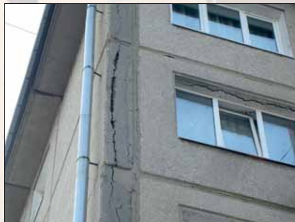
Техническое состояние панелей торцевой части здания по ул. Севастопольская, 255 в апреле 2013 г.
