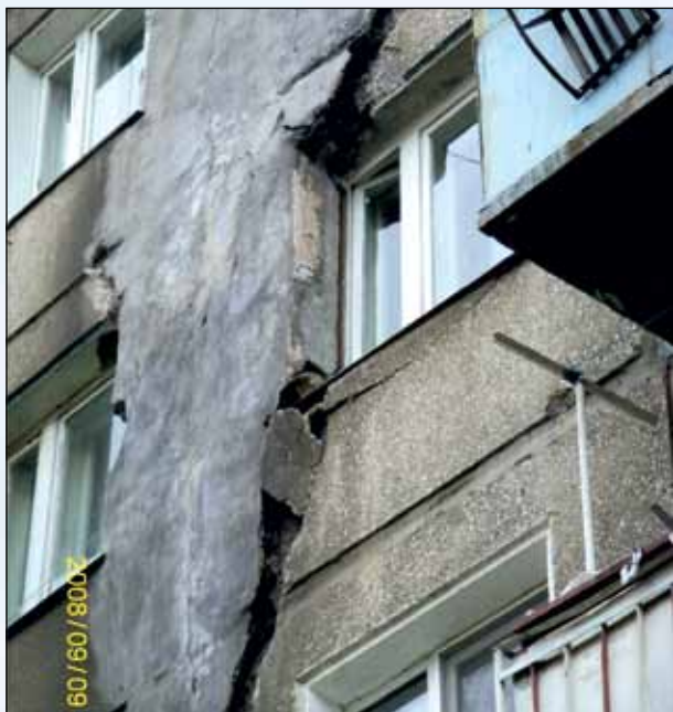
Состояние стеновых панелей дома по ул. Р. Люксембург, 311 после землетрясения 2008 г.
