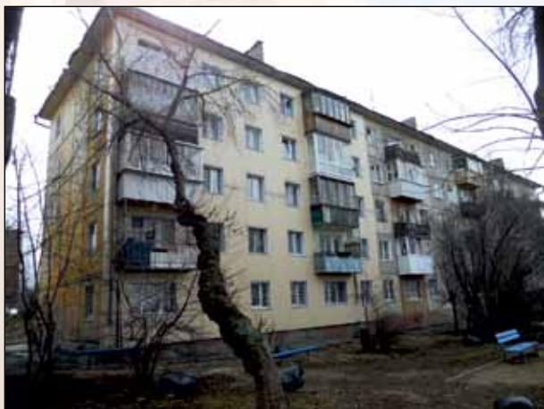
Главный фасад здания по ул. Дальневосточная, № 53 с частично восстановленным фасадом
