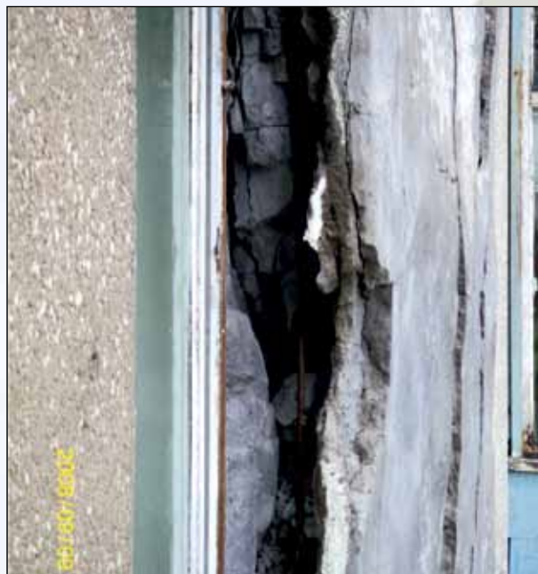
Состояние стеновых панелей дома по ул. Р. Люксембург, 311 после землетрясения 2008 г.
