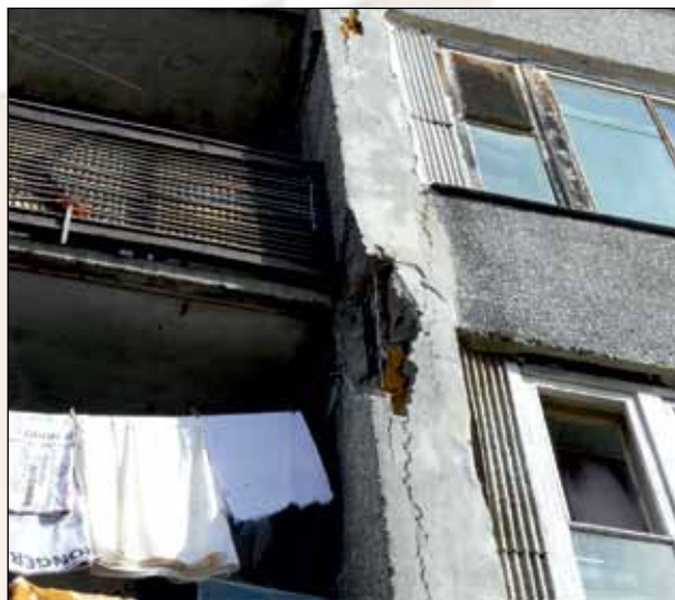
Проявление скрытых дефектов конструкций после ремонта панелей штукатурными растворами (мкр-н. Юбилейный № 2, 3, 4 – апрель 2013 г.)
