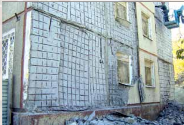
Типичное состояние строительной площадки на начальном и завершающих этапах восстановления наружных стеновых панелей зданий серии 1-335.
