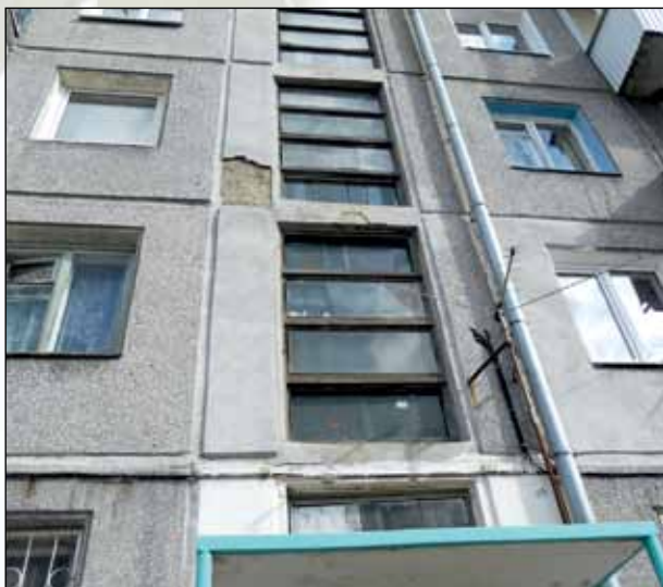
Проявление скрытых дефектов конструкций после ремонта панелей штукатурными растворами (мкр-н. Юбилейный № 2, 3, 4 – апрель 2013 г.)
